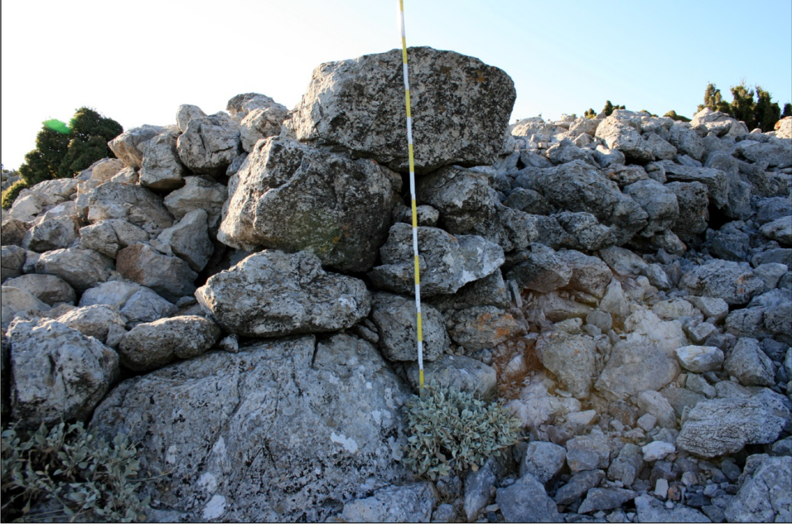
Resim 8. 1 no.lu kulenin kuzeydoğu köşesi, örgüde görece büyük bloklar kullanılmış (Polat 2010)
