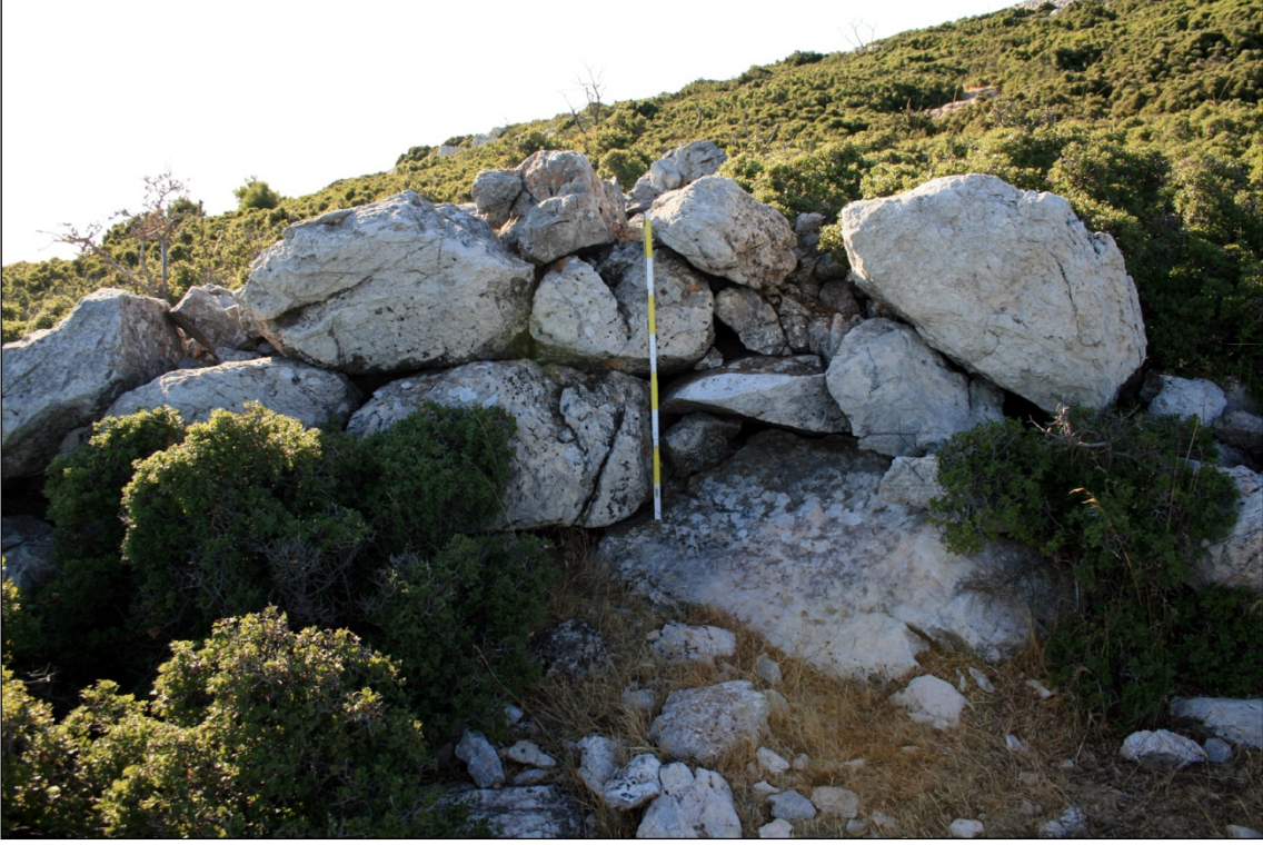
Resim 11. Aşağı şehir surları anakaya üzerine oturmaktadır (Polat 2010)
