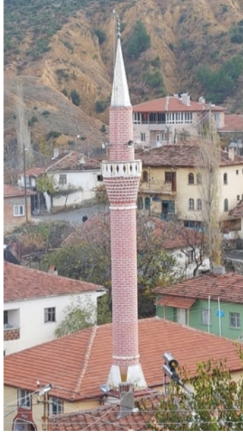
Şekil 6: Doğla Camii Minare (2021)
