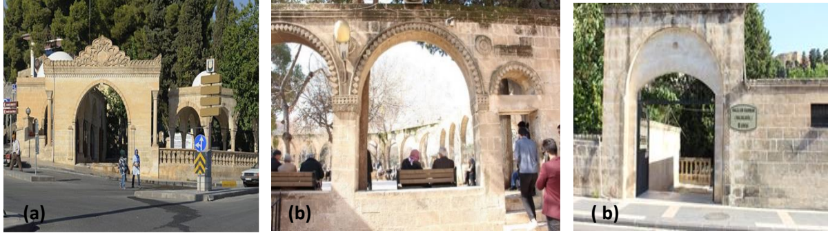
Şekil 7. (a) Şanlıurfa Bediüzzaman Mezarlığı giriş kapısı; (b) Balıklıgöl giriş kapıları.
