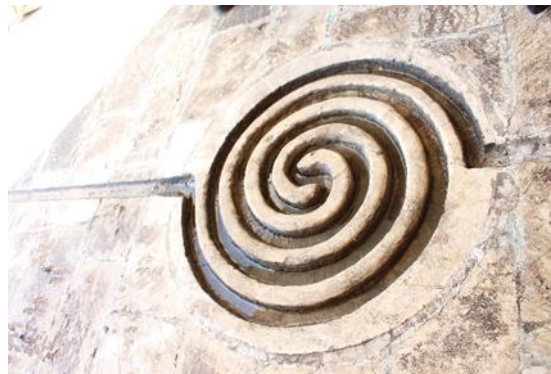
Şekil 12. Harran Üniversitesi Kültür Evi (Akçarlar Evi) eyvanında bulunan su yolu (çöpür taşı)
