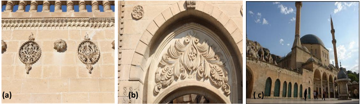
Şekil 6. (a) Hacıbanlar Evi Mutfak Müzesi havalandırma takası; (b) Harran Üniversitesi Kültür Evi (Akçarlar Evi) taç kapı; (c) Mevlid-i Halil (Dergâh) Cami.
