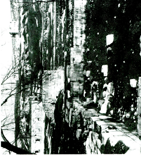
Abb. 6 Reste der Pulverfabrik in Azatli bei Istanbul (Foto: W. Schiele; Archiv DAI Istanbul R 15 063)
