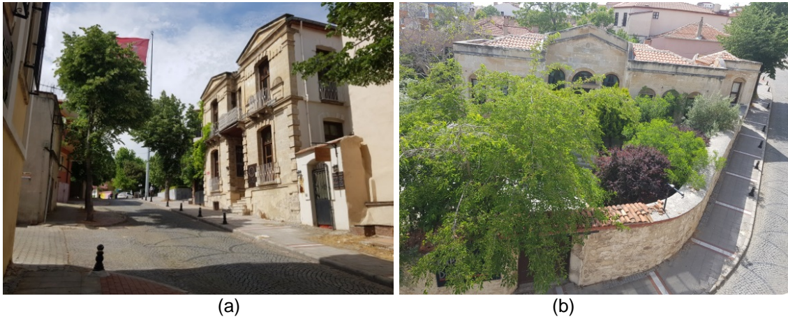
Şekil 5: Yapıların Yayla Caddesi üzerindeki konumları ve çevre ile ilişkileri (Gülcan M. Yeler, 2021)
