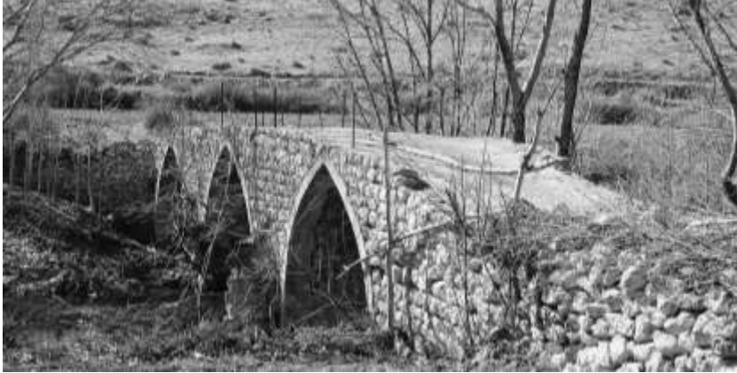
Fotoğraf 8. Hisarkaya Köyü Köprüsü'nün Genel Görünüşü.
