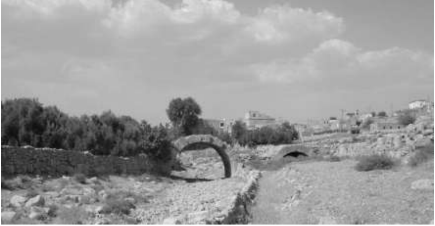
Fotoğraf 1. Dara I. Köprüsü'nün Genel Görünüşü.
