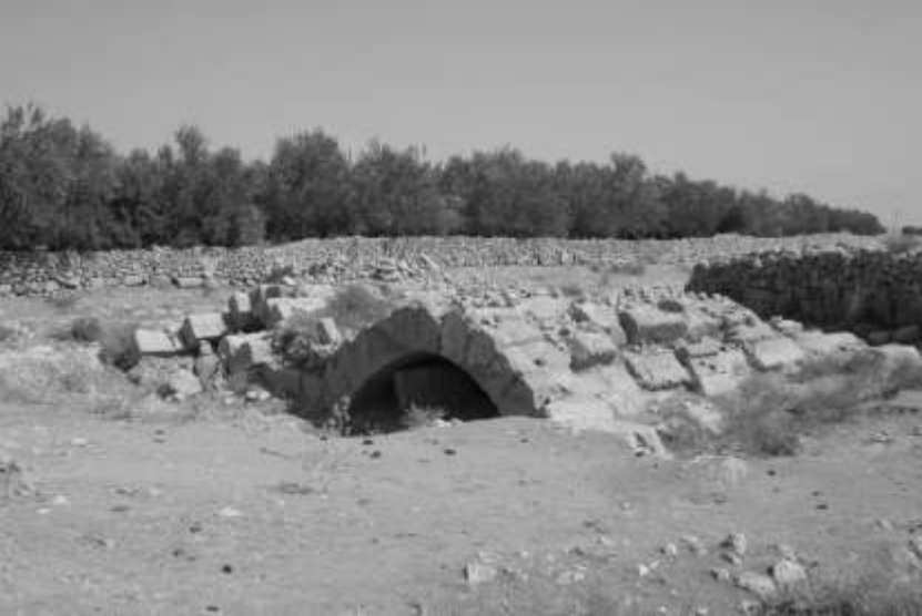
Fotoğraf 2. Dara II. Köprüsü'nün Genel Görünüşü.
