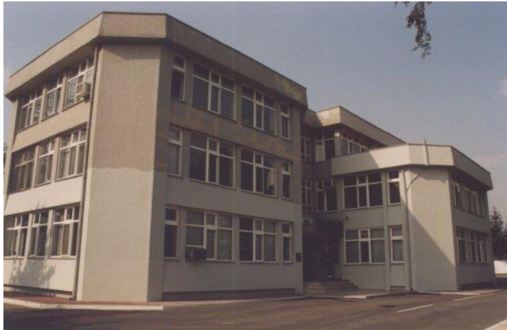
Gölçük Deniz Ana Üs Komutanlığı Binası, 2016.
