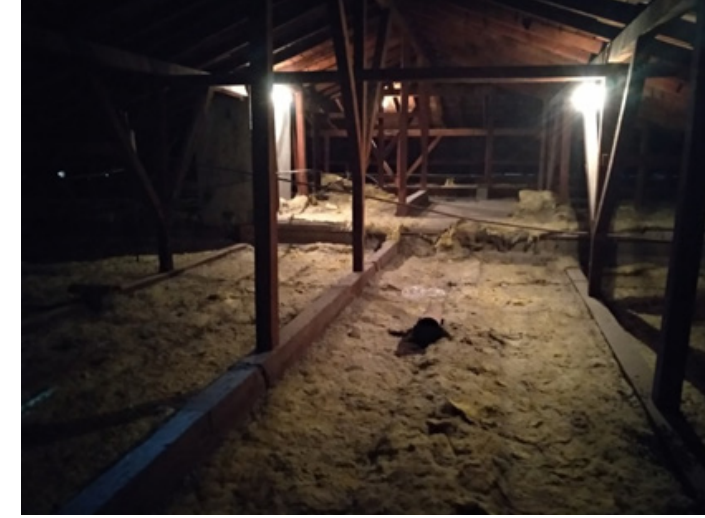
Görsel 12. Çatı izolasyonu (ÇMM, 2021)
