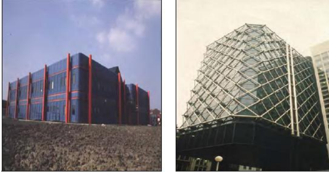
Şekil 5. Çelik kolonların içinden su dolaştırılarak yangına dayanımın sağlanması [5] (Figure 5. The examples of water circulation inside steel columns [5])
