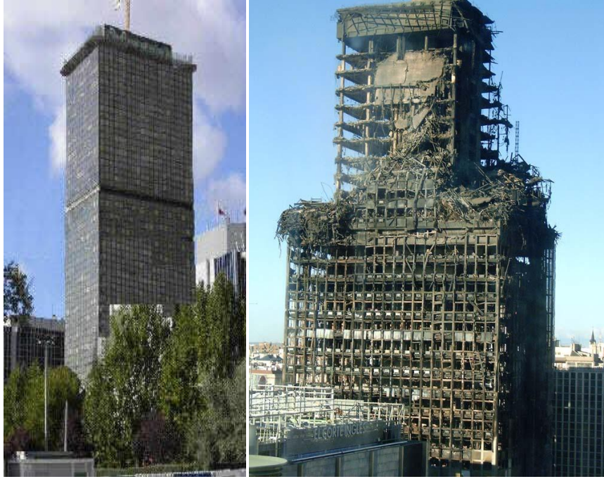
Şekil 2. 32 katlı Windsor Kulesi, Yangın öncesi ve sonrası durumu [5] (Figure 2. 32 Storey height Windsor Tower, before and after fire [5])
