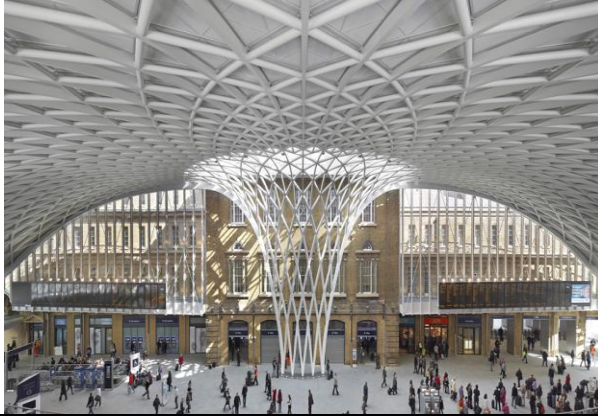
Şekil 4. Tarihi yapıda çelik kirişlemeli üst örtü uygulaması [22] (Figure 4. Steel beams applications at historical buildings)
