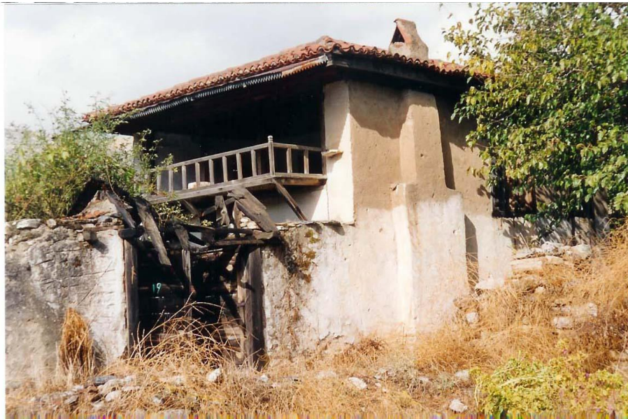
Şekil 4. Açık sofalı konut ön cephesi (Figure 4. The front facade of the house with open sofa)
