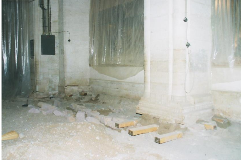
Şekil 7. Taşıyıcı fil ayağın (sütunun) yenilenmiş ahşap ızgara destekli temel sistemi (Figure 7. The foundation system of the structural dome column supported by the renewed wooden grid)
