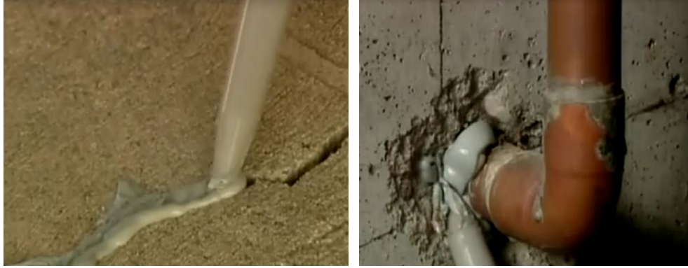
Şekil 10. Çatlakların Penetrasyonlu Dolgularla Tamiri (Şekil 10. Repairing Cracks by Penetrated Backfills)
