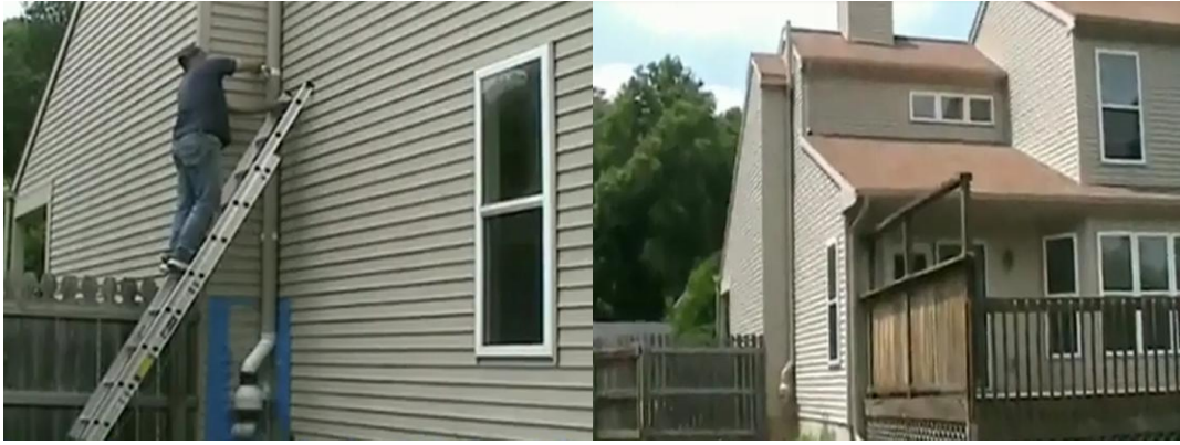
Şekil 5. Radon Yalıtım Mekanizmalarının Kurulumu (Figure 5. Application of Radon Insulation Mecahanisms)
