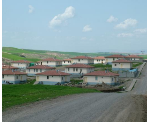
Şekil 12. Alibeyköy Konutları (Figure 12. Alibeyköy Houses)
