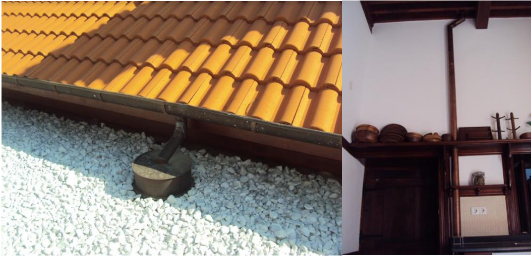
Şekil 6: Emine-Murat Koçak Evi yağmur suyu toplama çatı detayı ve oluk sistemi (Fotoğraflar: Nilgün Akman)
