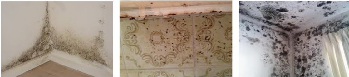
Resim 2. Islak hacimde ve iç mekanda küf mantarı oluşumları [11, 12 ve 13] (Image 2. Mold formation on wet surfaces and interiors of structures)
