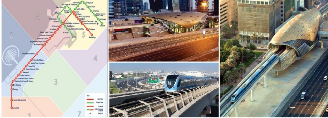
Şekil 1. Dubai Metro projesi (Figure 1. Dubai Metro project) [15 ve 16]
