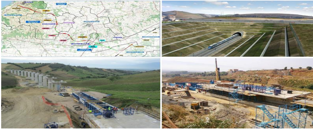
Şekil 4. Birtouta-Zeralda banliyö treni projesi (Figure 4. Birtouta-Zeralda railway line project) [26, 27 ve 28]
