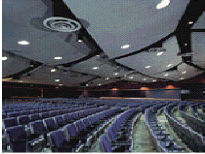
Resim 3. Salonlarda tavan yüzeyi kırıklı ve ses yutucu özelliklerde olmalıdır
