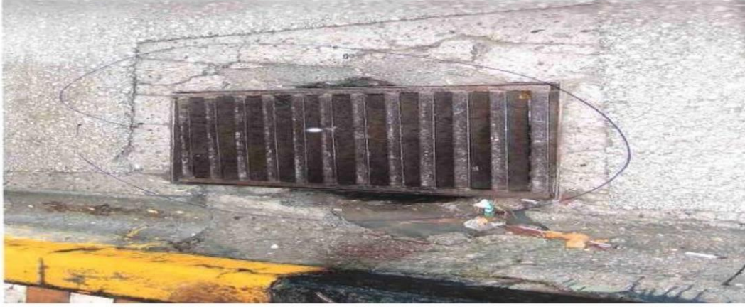
Şekil 95. Dökme pik yağmur suyu tahliye ızgarası Figure 95. Molten Cast Iron Rain Water Discharge Grill
