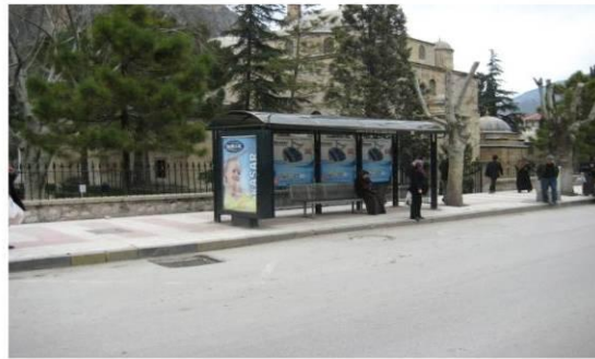
Şekil 77. Üstü Plastik Örtü Otobüs Durağı Figure 77. Bus-stop with Plastic Covering
