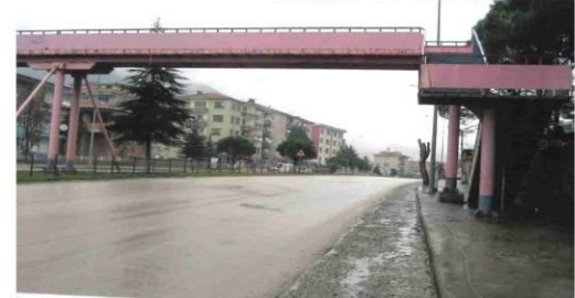
Şekil 74-75. Atatürk Bulvarı Yaya üst Geçiti Figure 74-75. Atatürk Boulevard Pedestrian Overpass
