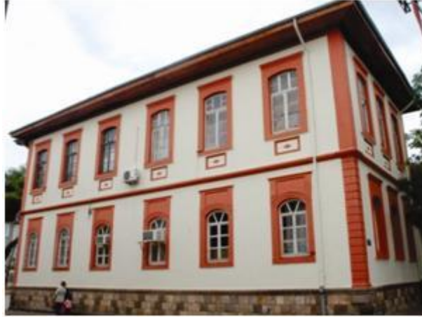
Şekil 6. Edremit Hükümet Konağı Gazi Caddesi Cephesi Görünümü (Figure 6. Edremit State Mansion Gazi Street Facade)
