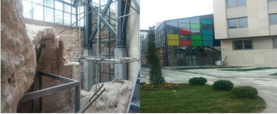
G. 9: Kalıntının Korunarak Binanın İnşası (Cemil Akçay, 2017)
