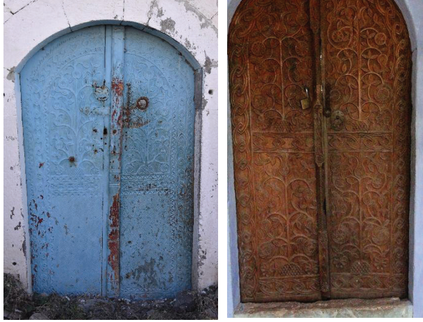
G. 33: Ahşap Kapı Kanatları (Güvenlik Köyü Camii, Gökler, 2020)
