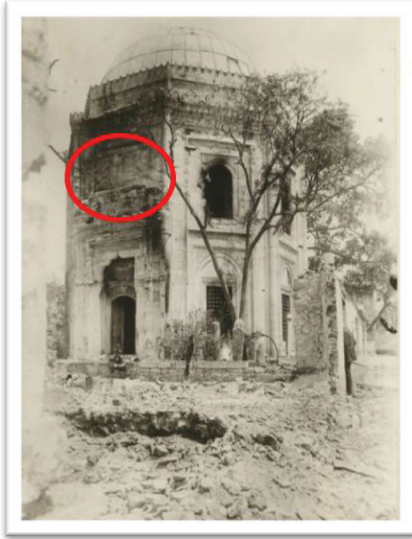
G. 22: Hüsrev Paşa Türbesi Güneybatı Cephesindeki Ahşap Saçak/Paraçol İzi (Salt TASUDOC01760052402)
