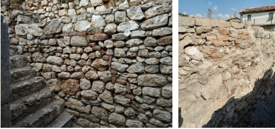
G. 10: 2016 yılında yapılan sağlamlaştırma müdahaleleri a) doğu koridoru b) batı koridoru (Acun Özgünler, 2017).
