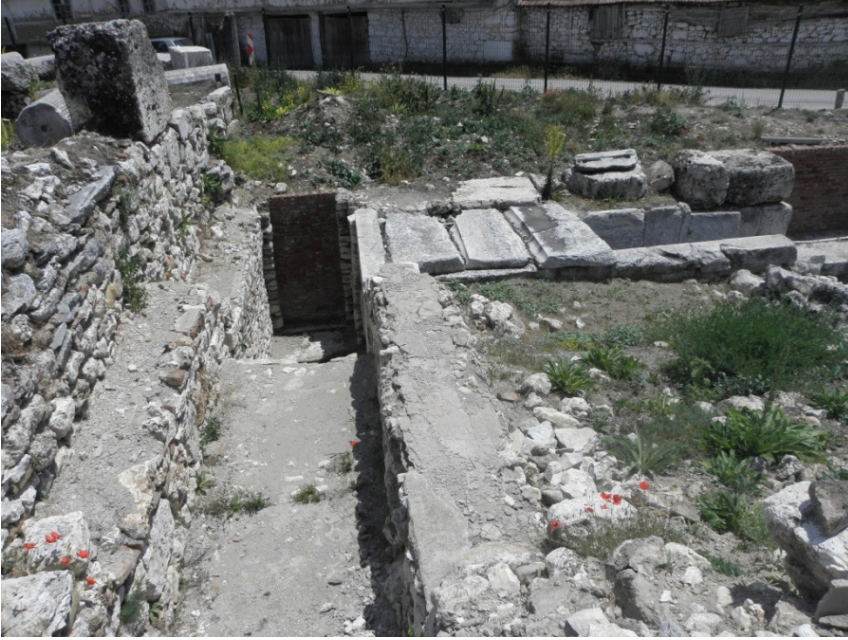
G. 14: Yapı duvarları üzerindeki çimento esaslı harç tabakaları (Acun Özgünler, 2017).
