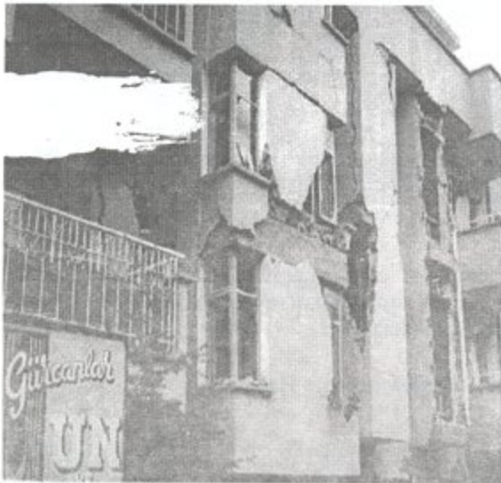
Şekil 4 Düzensiz yapılmış ve depremde kullanılamaz hale gelmiş bir yapı
