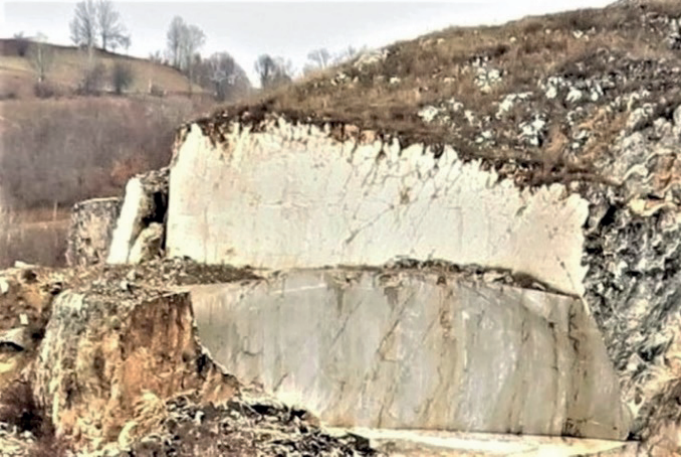
Şekil 4: Doğal tünelin içerisinde geliştiği açık gri renkli kireçtaşları ve içerisindeki çatlak sistemleri.
