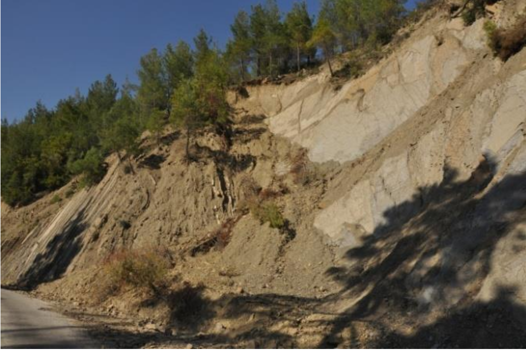
Foto 13. Köprülü Kanyon (Köprü Çayı havzası, Serik) dolayında yamaç eğimi ile tabaka eğiminin aynı olduğu yamaç eteğinde geçirilen yol yarmasında oluşan heyelan
