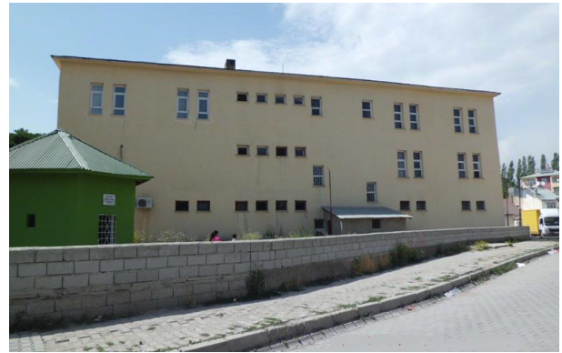
Şekil 2. İncelenen binanın mevcut durumu. (Current situation of the examined building)
