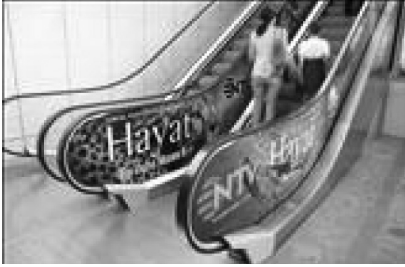
Adrail uygulaması-NTV Hayat
