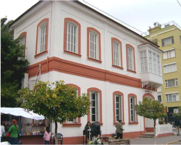
Şekil 18. Eski Vali Konağı (Öğretmen Evi)
