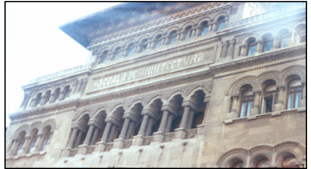
Şekil 2.3. Neo Romanian Stili ile inşa edilmiş olan The Place of The School of Architecture Binası (Dabija, 2006)
