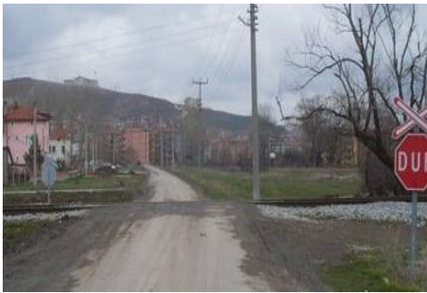
Şekil 1. Bariyersiz bekçisiz hemzemin geçit [16]
