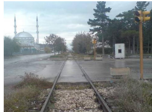
Şekil 7. Beton-prefabrik kaplamalı hemzemin geçit [16]
