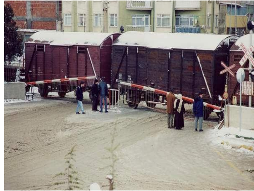
Şekil 2. Bariyerli bekçili hemzemin geçit [7]
