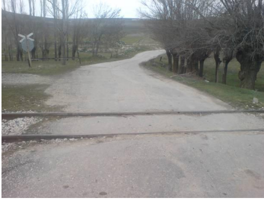
Şekil 8. Asfalt kaplamalı hemzemin geçit [16]
