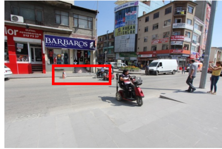
Şekil 4. Yaya geçidinin diğer kısmındaki rampa eksikliği
