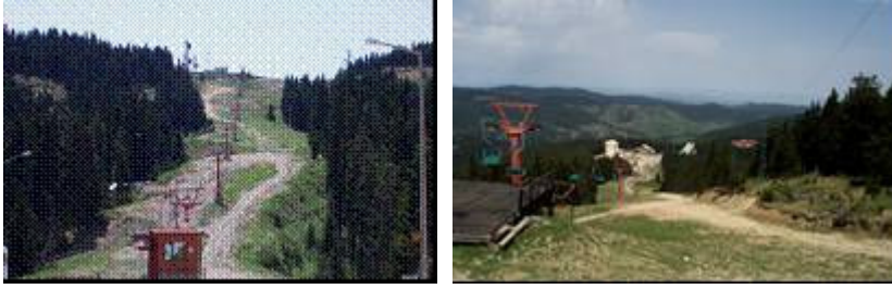
Şekil 3. Çalışma alanı içerisinde yer alan mekanik tesis
