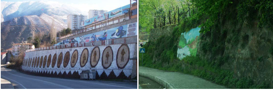
Şekil 8. Kent merkezinde bulunan istinat duvarlarına ait görüntüler
