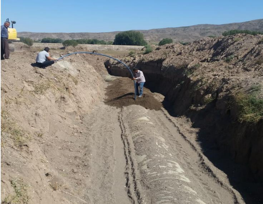
Şekil 3. Arazide borunun döşenmesi.
