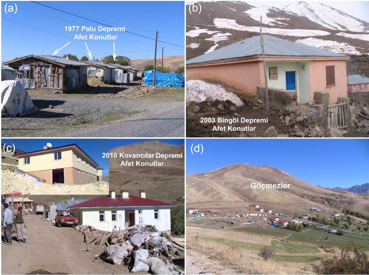
Fotoğraf 7. Kovancılar doğusunda yaşanan deprem sonrasında TOKİ tarafından yapılan konutlar ((c) Okçular; (d) Göçmezler). 1977 Palu ve 2003 Bingöl depremlerinden sonra yörede çok sayıda deprem konutu yapılmıştır (a), Tabanözü; (b) Kayalık). Bu durum 1977'de Palu-Hazar, 2003'de Karlova-Bingöl segmentlerinin kırıldığını göstermektedir.
