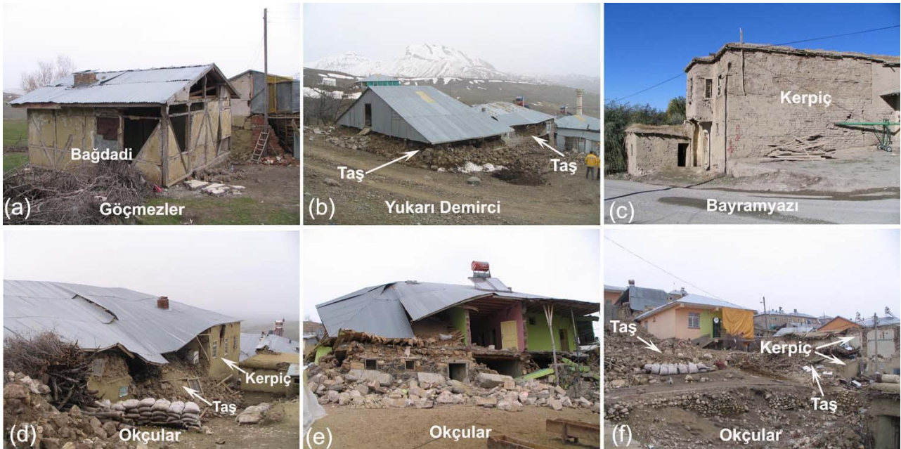
Fotoğraf 6. Kovancılar-Okçular depreminde yüksek hasarın olduğu alanlarda çeşitli ve karmaşık yapılar görülmüştür ((a) Göçmezler, (b)Yukarı Demirci, (c) Bayramyazı, (d), (e), (f) Okçular)
