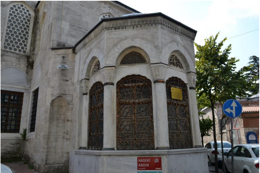
Fotoğraf 33: Bayrampaşa Sebil-i Cerrahpaşa
