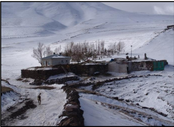
Fotoğraf 3. Ramazan Seylan'a ait kom evi ve eklentileri. Kafeterya olarak düşünülen konut diğerlerinin aksine betonarme, demir kapı, izolasyonlu pencere ve sac örtülü çatıya sahiptir.
