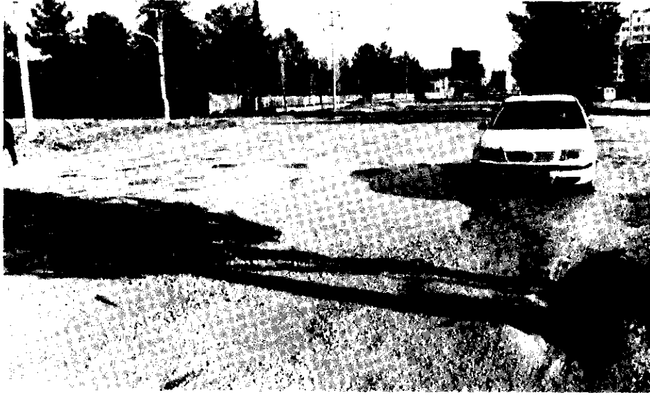
Foto 7- Atatürk Bulvarının yol yapımından bir görünüş. Photo 7- A view from Atatürk Boulevard construction.
