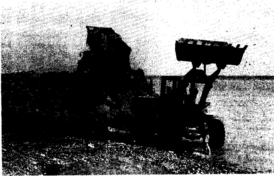
Foto 10: Samsun şehir suyu borularını dalga tesirinden korumak amacıyla kıyı çizgisi üzerinde yapımına başlanan bariyer.
