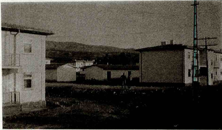
Foto 6 - 1986 yılında vuku bulan Doğanşehir-Sürgü Depremi'nde evleri yıkılan depremzedeler için yapılan 228 adet dublex tipi evler ve tek katlı ahırlardan bazıları. Bunlar, Gölbaşı'nın kuzeybatısında fay hattının yakınında bulunmaktadır.
