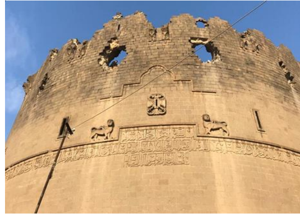
Şekil 2. Yedikardeş Burcu güney cephesi
