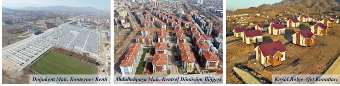
Şekil 2. Yeniden yapılandırma etaplarına ait örnekler.
