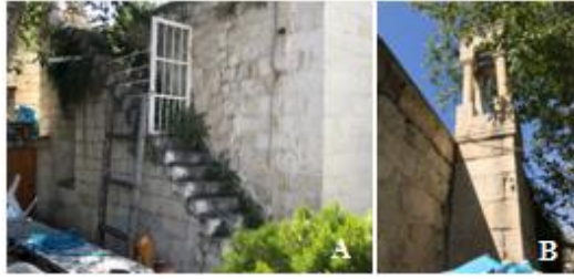
Fotoğraf 11: Bahçeli Cami Minareye Çıkan Merdiven, B.Köşk Minare, C.Kuzey Beden Duvarı (F. Toruk Arşivi)
