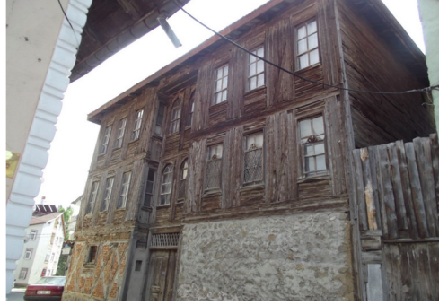
Resim 2. Hacı Mehmet Ali Konağı – Ahşap Çatkı Arası Ahşap Dolgu Örneği (Kişisel Arşiv- 21.09.2017)
