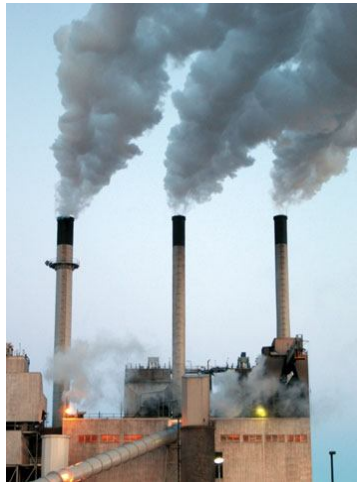
Şekil 4. Termik santraller en önemli cıva kaynağıdır.
