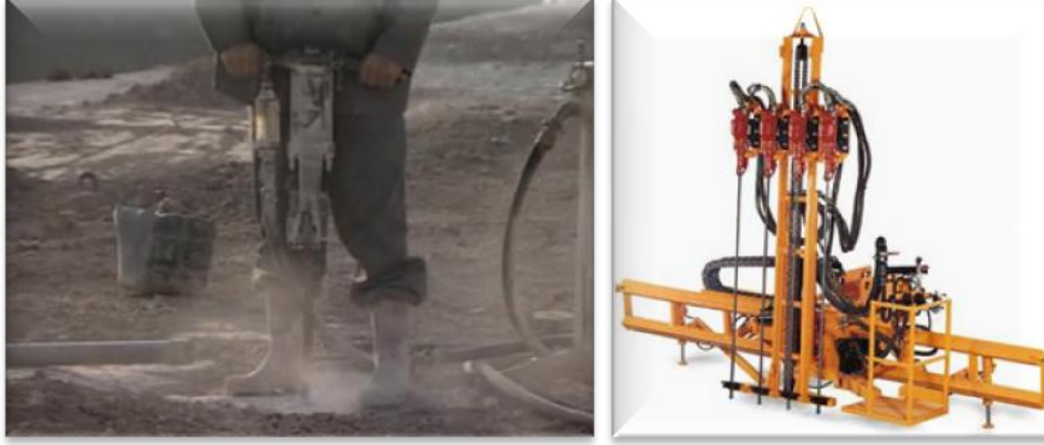
Şekil 4 Delme çatlatma yönteminde deliklerin açılması [10]
