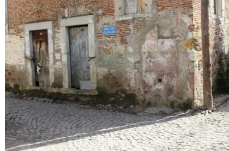
Merkez Hastane Caddesi 4.Sokak 4. Arada bulunan Ayazma Kilise Çeşmesi
