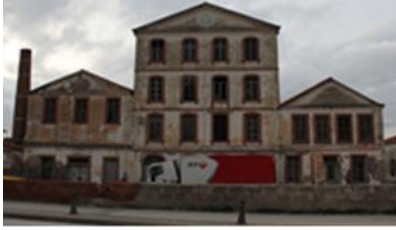
Madra Zeytinyağı Fabrikası ve Sabun İmalathanesi
