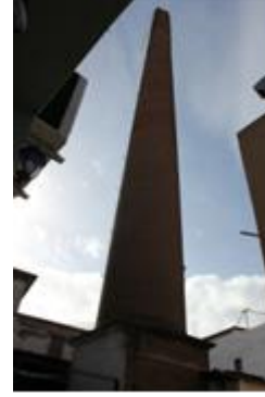
Bir zeytinyağı fabrikası bacası
