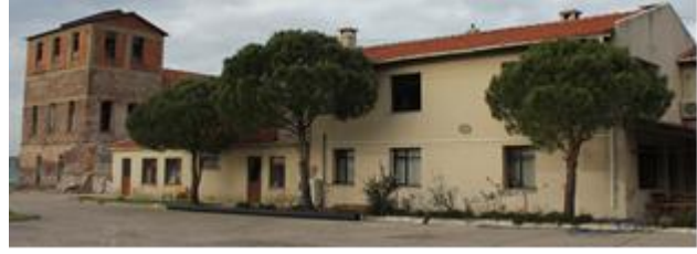
Kurlangıç Zeytinyağı Fabrikası
